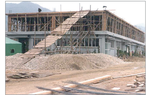
중앙전자공업 성남공장 2층 증축공사(1978)
