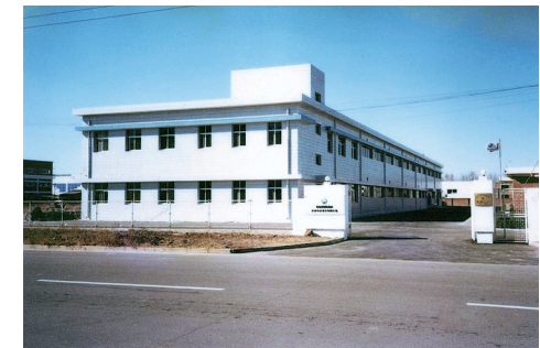
중국 천진 공장 전경(1998)
